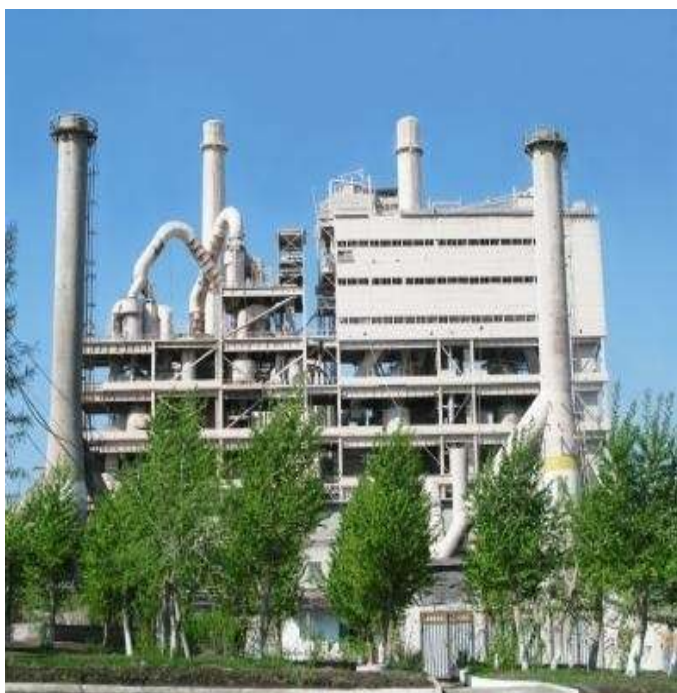
АО «Катавский цемент»
