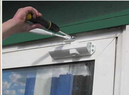
Установка дверей с устройствами само закрывания и уплотнениями в притворах на путях эвакуации
